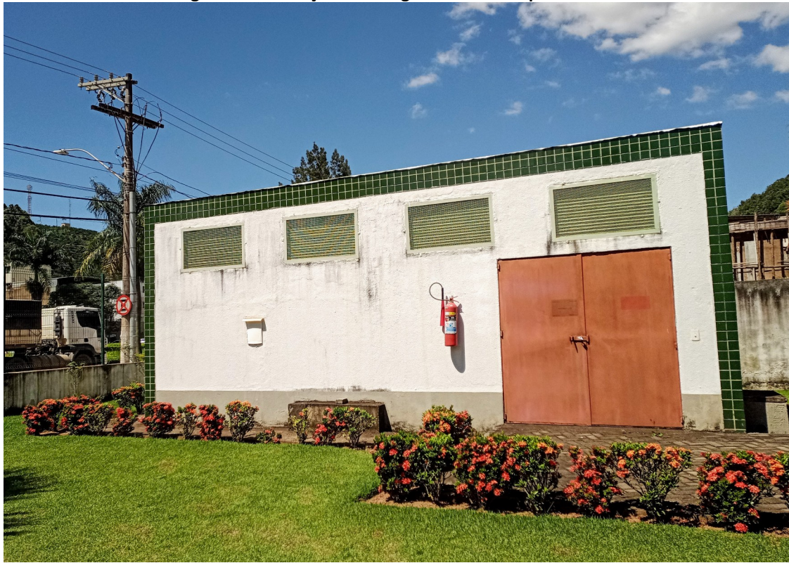
Figura 1: Subestação de energia do Ifes - Campus Ibatiba.
